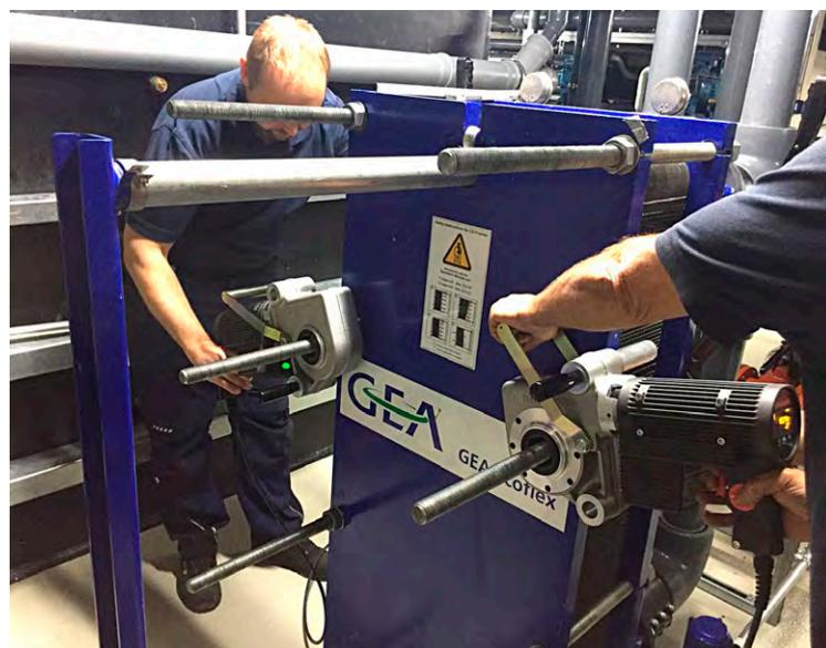
**Empfehlung:** Einsatz von zwei alkitronic® Drehmomentschraubern für die Steigerung der Produktivität, zur Entlastung der Schrauber bei großen Plattenpaketen und für eine Verlängerung der Lebensdauer der Dichtungen.
